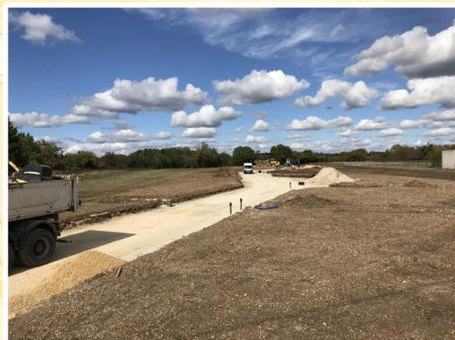
~ Le piquetage pour délimiter les terrains (bornage) et les voies d'accès a été réalisé et la société Picoulet est intervenue par la suite pour décaisser et mettre en calcaire les voies d'accès.
