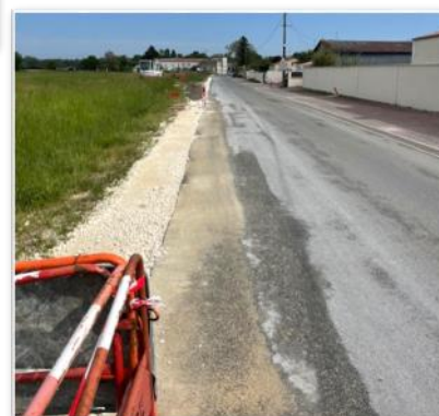
Enfouissement, tranchée refermée
